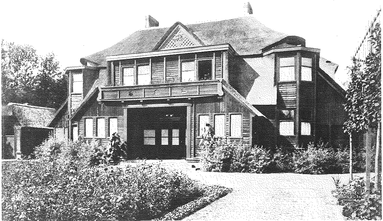
Villa personnelle de Henry van de Velde « De Tent » à Wassenaar, 1922. Reproduction d'une photographie d'époque conservée au Musée de la Littérature (Bibliothèque Royale Albertine à Bruxelles).
