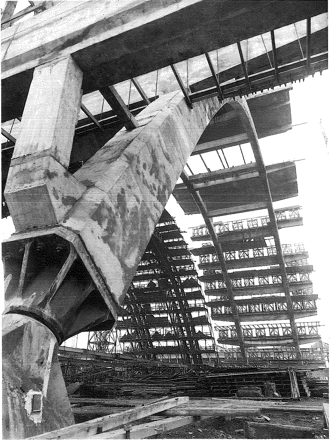
Exposition universelle et internationale de Bruxelles en 1935, le Grand Palais en construction, plateau du Heysel à Bruxelles (ingénieur L. Baes), 1934-1935. Photographie d'époque.
