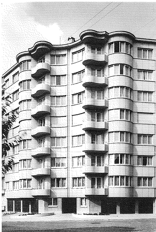
Immeuble à appartements Le Cervantes, avenue A. Bertrand 51 à Forest (Bruxelles) (collaborateur J. Thomas), 1951. Photographie J. Balossier.
