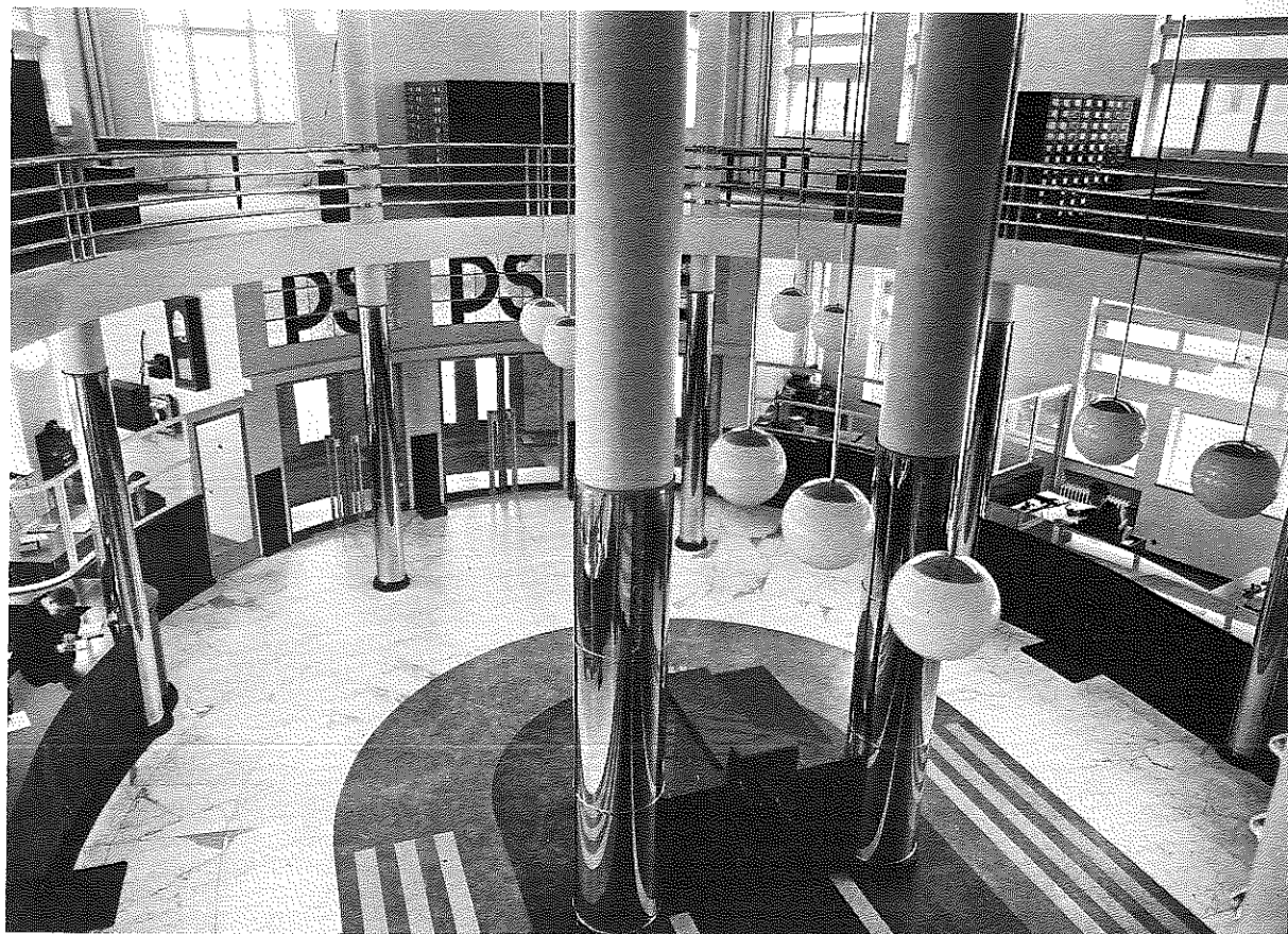
Aménagement du hall d'entrée de l'immeuble de la « Prévoyance Sociale », square de l'Aviation à Bruxelles (collaborateur F.Brunfaut), 1931. Photographie Kessels.
